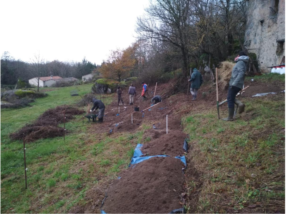
Chantier de plantation
