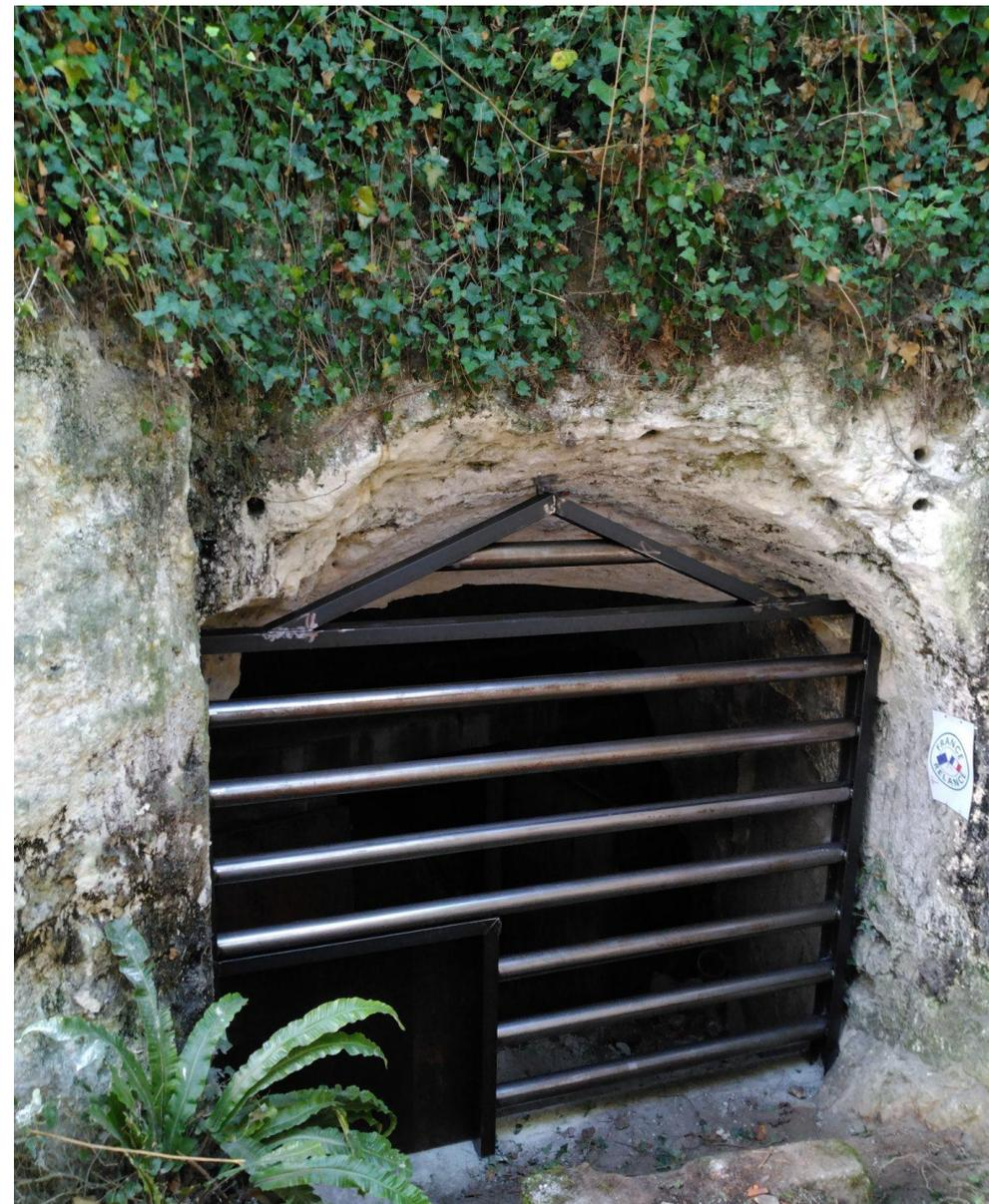
Grille renforcée, avec trappe anti-vandale (barreaux pleins de 8cm de diamètre, verrou caché)
